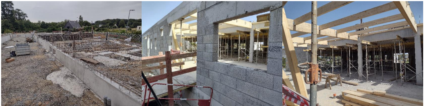
Des fondations, au gros œuvre et la pose de la charpente
